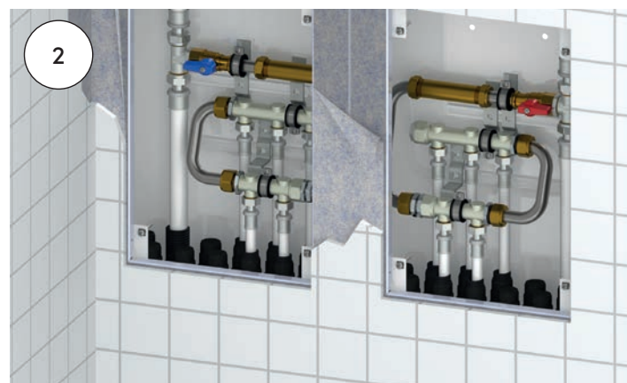
2. På skåpens våtzonsramar, med dess pålimmade flänsar, appliceras sedan lim och tätskikt och slutligen ytskikt.
