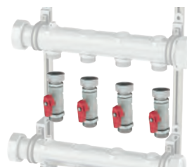
Kulventiler för slingutgång
